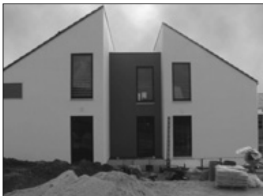
Ringsum noch Baustelle, ein Detail der Nordansicht der entstehenden RehaSalus
