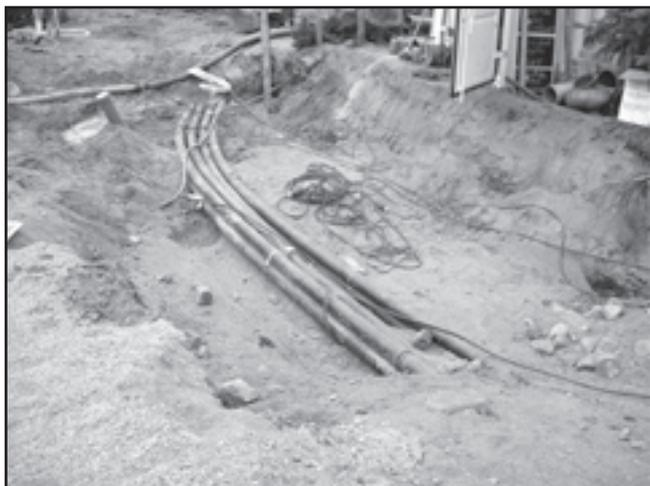
Ein Beispiel für quer durch das Baufeld verlaufende Leitungen anderer Medienträger
