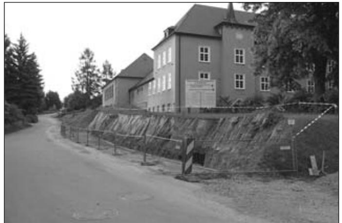
Im Rahmen des Grundhaften Ausbaus der Cosuler Straße wird innerhalb der Ortslage bis einschließlich der Cosuler Siedlung ein kombinierter Geh- und Radweg errichtet. Entlang der Lessingschule ist dazu eine Stützmauer erforderlich. Im Bild sind die vorbereiteten Erdarbeiten für die Schal- und Betonierarbeiten zu erkennen.
